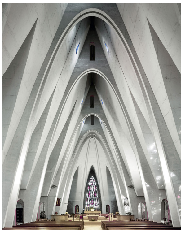
Figura 8: Empleo de los arcos catenarios en la Iglesia de Saint Martin en Donges, Francia (fotografía de Fabrice Fouillet).
