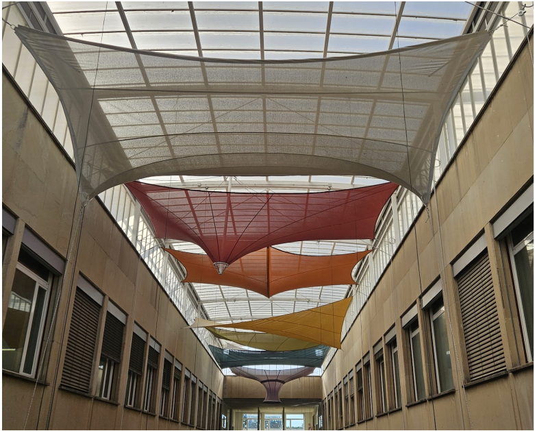
Figura 9: Toldos del pabellón nuevo de la ETSAM.
